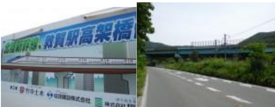
北陸新幹線拡張工事
